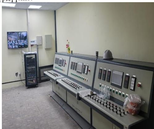
Зураг 3.20. Сэлбэ дэд төвийн дулааны станцын тоног төхөөрөмж угсралтын ажил
